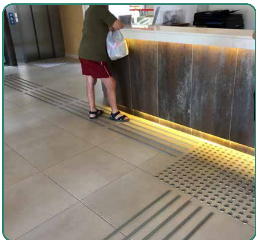
Iluminación adecuada./ Fuente: La Ciudad Accesible.
