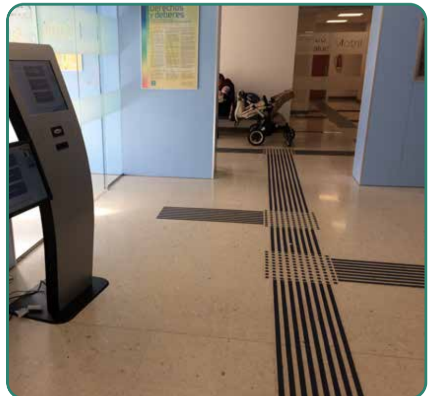
Pavimento táctil./ Fuente: La Ciudad Accesible.
